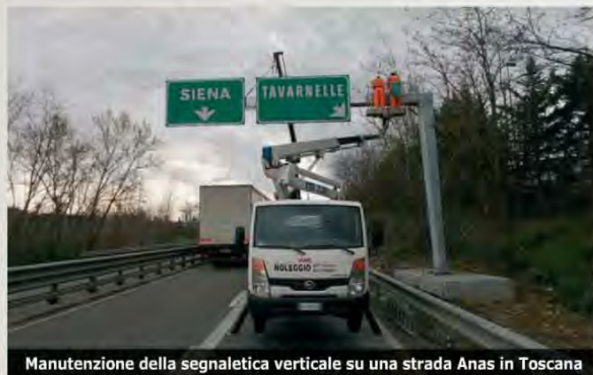
Manutenzione della segnaletica verticale su una strada Anas in Toscana
